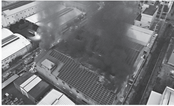
圖十一：太陽能案場發生火災實況
